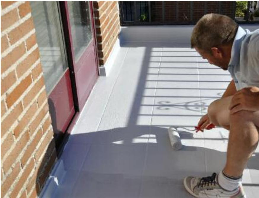
Sistema impermeabilizante apto para cubiertas que no soportarán tránsito. Para mejorar las propiedades de resistencia en general, puede reforzarse con geotextil.
