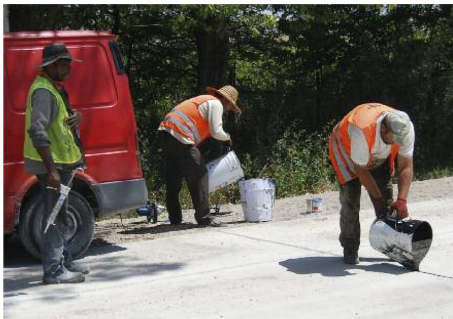
labios de la junta, al tiempo que endurece la superficie y fija el polvo. Para juntas en inmersión permanente el uso de imprimación es ineludible.
