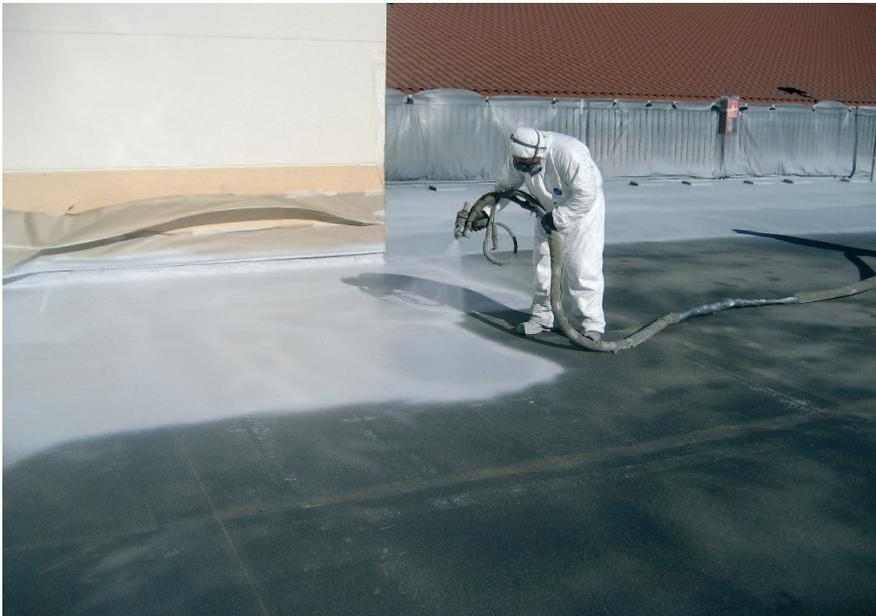
Sistema impermeabilizante, para cubiertas, forjados y soleras con protección mecánica y a la luz en acabado antideslizante recomendado para zonas con tráfico vehicular.
