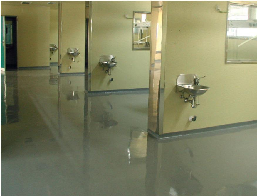
Un autonivelante de resina es un mortero fluido de resina con árido de sílice fino, el cual, aplicado a llana dentada y tras un proceso de des-aireado mediante rodillo de púas, genera una superficie lisa y plana. Se aplica en espesor de 1-2 mm. Su acabado final confiere a este sistema buenas propiedades higiénicas por su facilidad de limpieza, resistencias físicas y químicas y un aspecto estéticamente atractivo.
