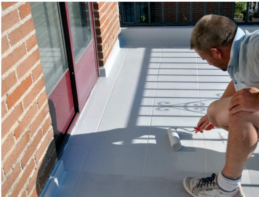
Sistema impermeabilizante de buena resistencia química, apto para cubiertas que no soportarán tránsito. Atendiendo al hecho que éstos sufren alteraciones de color tras su exposición a los rayos ultravioleta, se recomienda aplicar una protección adecuada.
