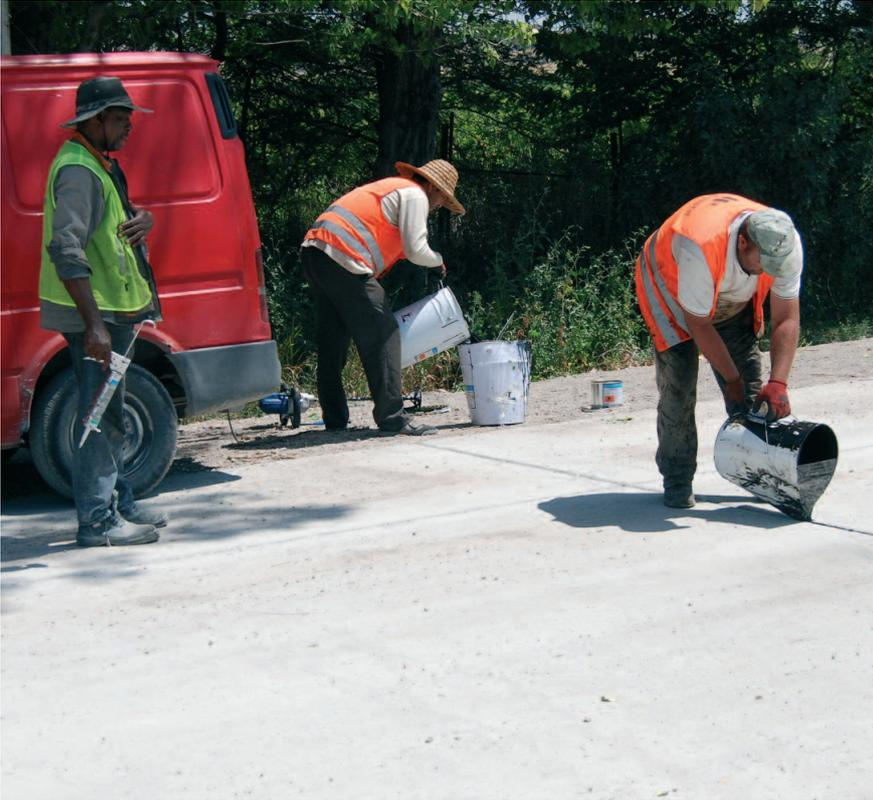
**MASTIKPOL:** Masilla monocomponente de poliuretano para el sellado de juntas. Polimeriza con la humedad ambiente sellando la junta de forma elástica y duradera. Elasticidad  $\geq 200\%$ . Para el sellado de juntas en prefabricados pesados y ligeros, juntas en pavimentos industriales, en paredes y techos y el pegado y fijación de elementos de construcción no estructurales: tejas, paneles, mamparas, azulejos, etc.
