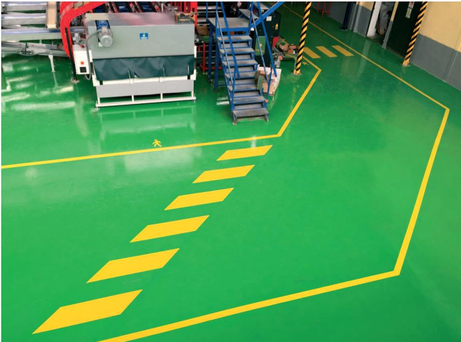
Un autonivelante de resina es un mortero fluido de resina que admite una adición de arena fina de sílice, el cual, aplicado a llana dentada y tras un proceso de des-airado mediante rodillo de púas, genera una superficie lisa y plana. Se aplica en espesor de 1-2 mm. Su acabado final confiere a este sistema buenas propiedades higiénicas por su facilidad de limpieza, resistencias físicas y químicas, además de un aspecto estéticamente atractivo.
