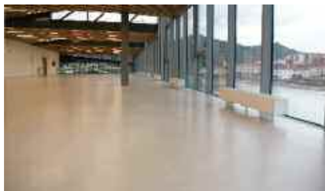
Clube de Remo em Orio (Vizcaya) Nivelamento com ARDEX IFS
