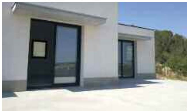
Vivienda Privada (Maiorca) Pavimento exterior com ARDEX CD
