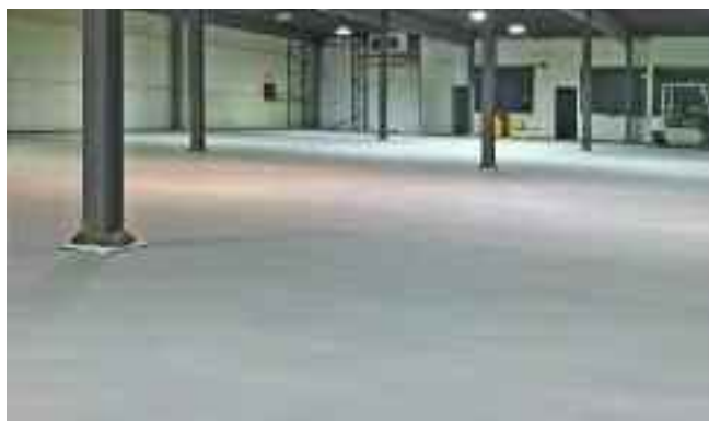
Nave Zunibal (Vizcaya) Nivelamento com ARDEX IFS
