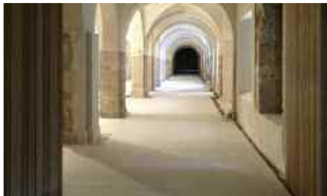
Mosteiro San Zoilo (Palência) Primário do suporte com ARDEX EP2000 Revestimento com panDOMO® TerrazzoMicro
