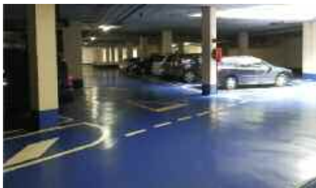
Estacionamento do edifício MAS BLAU (Barcelona) Nivelamento com ARDEX IFS
