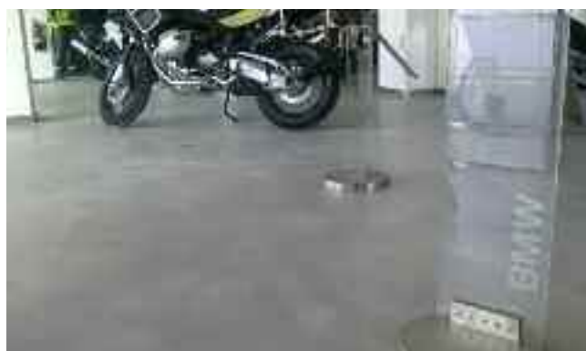
Concessionário BMW (Zaragoza) Primário do suporte com ARDEX EP2000 Revestimento com panDOMO®Loft
