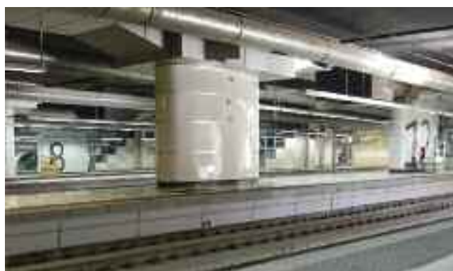
Estação Barcelona Sants Betonilha com ARDEX A38
