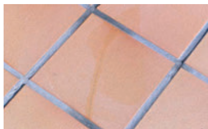
Aparición de fisuras debidas a movimientos extremos.
