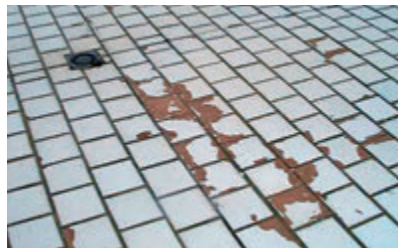
Roturas, desconches y desacoples por causa de las heladas.
