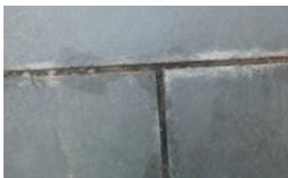
La formación de sales y eflorescencias.
